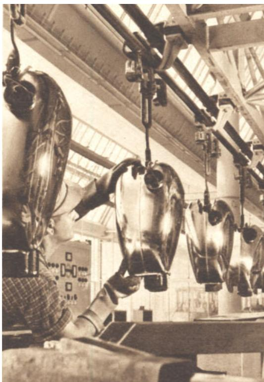
I serbatoi di benzina passano ininterrottamente dagli impianti di verniciatura.
